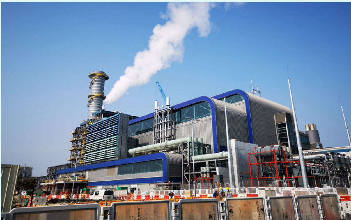
龍鼓灘發電廠一台 550 兆瓦的新建聯合循環燃氣渦輪機組預計於 2020 年投產。
