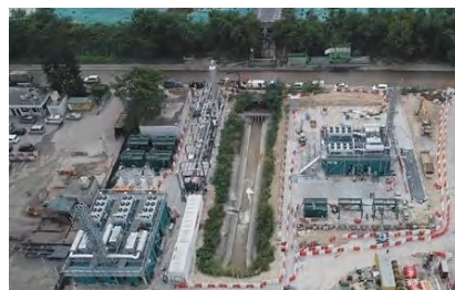
項目工地全貌
