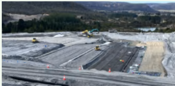
在 Mount Piper 電廠設置滲濾液屏障管理系統
