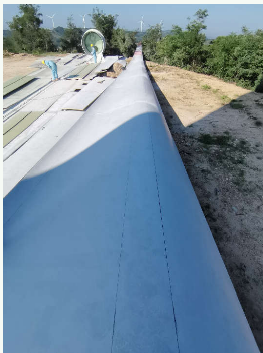
切割和粉碎以回收和重新利用退役風力渦輪機機葉的過程
