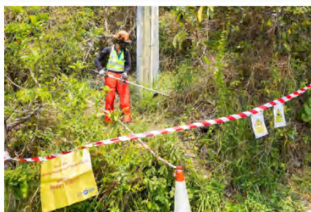
中華電力人員進行電杆清理工作，移除附近的雜草和樹枝，減少山火對電力系統造成的潛在影響。
