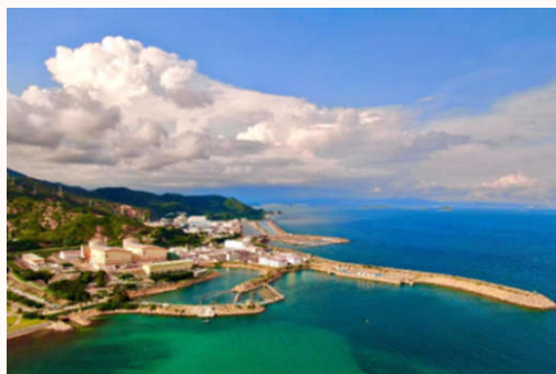
大亞灣核電站於 1994 年投產，逾 30 年來持續為香港提供安全、穩定且零碳排放的核電，滿足全港四分之一的電力需求。
